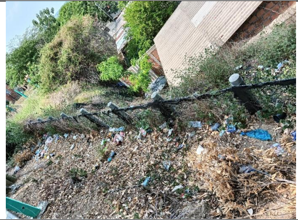
Foto 16. Pilotes de contencion de talud hacia predios vecinos, con canales de concreto completamente colapsados de basura y material vegetal.
