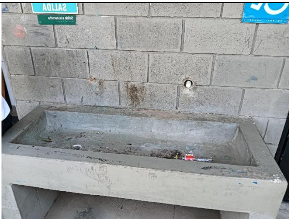
Foto 13. Lavamanos y bebederos sin uso por rotura y pérdida de grifería, taponados sin suministro de agua.
