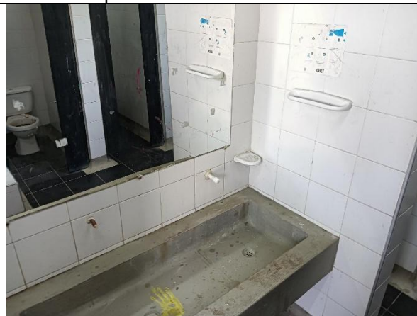
Foto 14. Mayor parte de los lavamanos han tenido rotura de vástago de grifería en pvc, por lo que la dirección ha eliminado griferías de todas baterías de baños.
